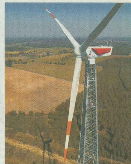
Najwyższa elektrownia wiatrowa powstała w okolicy miejscowości Laasow (Niemcy). Jej kratowa wieża ma wysokość 160 m, a elektrownia łopata swojego wirnika sięga 205 m
